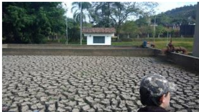
Figura 14. Visita à ETE
